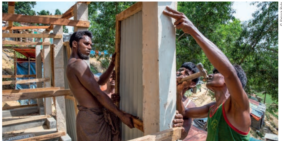
Participer à la construction de latrines permet de recevoir un précieux revenu d'appoint.
